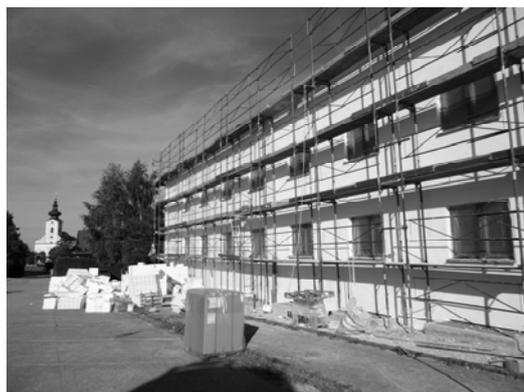
Einen Großteil der Stemm- und Abrissarbeiten für den ersten Bauabschnitt (Ostrakt) haben wir in den ersten 6 Monaten geschafft. Nun sind die Maurer, Elektroinstallateure, Heizungsbau- und Sanitärmonteur voll im Einsatz. Im Außenbereich wird eifrig am Vollwärmeschutz gearbeitet. Ebenso ist die Montage der Außentüren und Fenster natürlich mit Passivhausstand abgeschlossen.
